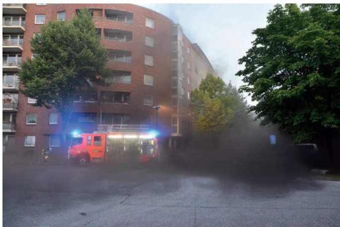
Abb. 6.1 Brand in einem Hochbunker. Kalter Rauch einer unvollständigen Verbrennung zieht in Bodennähe über die Straße (Quelle: Pressestelle Feuerwehr Hamburg).
